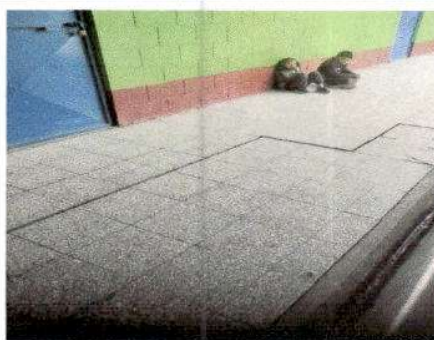
Foto 6: Sustitucion de piso rajado por piso de granito
